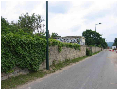
Le mur chemin de ronde
