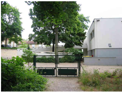
La crèche vue du Parc
